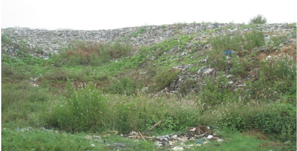
Gambar 5. Timbunan sampah yang sudah lama ditinggalkan di Zona I TPA Pecuk Kabupaten Indramayu (luas 1,2 ha dengan kapasitas 77.791 M 3 )
